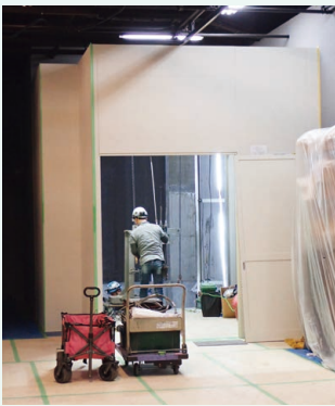
資料運搬用エレベーター工事の様子
